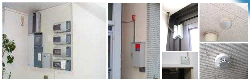
セキュリティシステム中枢 (Security system central), 外盤と異常時ライト (External disk and abnormal light), 防犯センサー (Security sensor), 人体感知空間センサー 煙探知センサー (Human body detection space sensor, smoke detection sensor)
